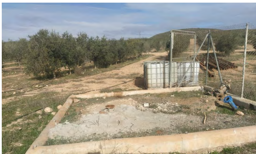
Figura 1: Sondeo nº292 del T. M. DE Tabernas a sustituir
